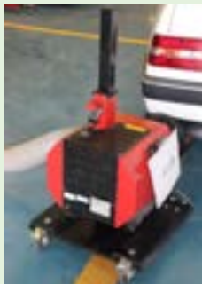
شکل ۳۲-۸- استفاده از دستگاه آگزوز فن
