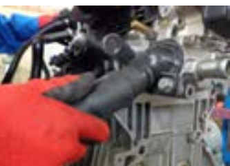
۸- شلنگ و اتصالات نصب گردد.
